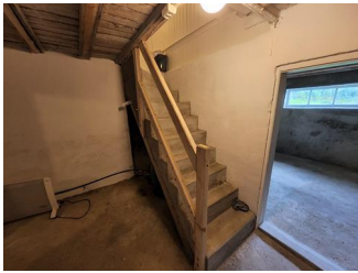
Rekkverk og håndløper - .
