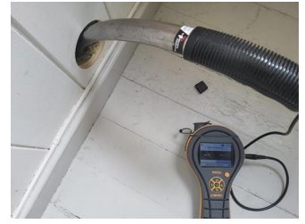
Utført kontroll i tilliggende konstruksjon - .
