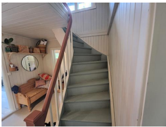
Rekkverk og håndløper - .
