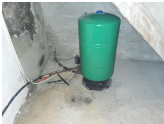
Varmtvannsbereder - Trykkvannspumpe.
