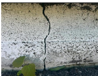
Grunnmur og fundament - -
