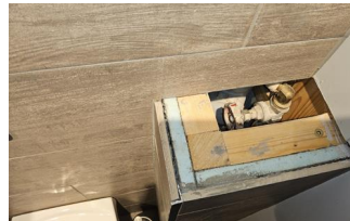
Innvendig stoppekran - Hovedstoppekran.
