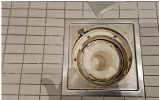
Tettesjiktets tilslutning til sluk - Sluk i dusjsonen.
