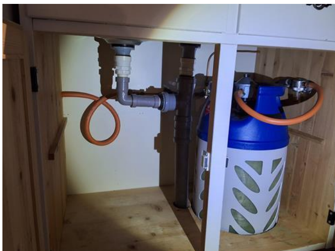
Kjøkken - [Rørapplegg og gassflaske i kjøkkenbenk]
