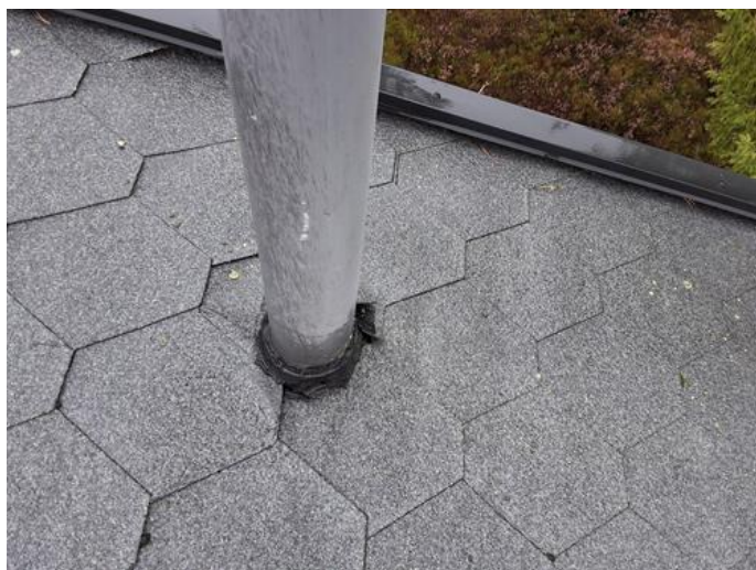
Utvendig - [Takgjennomføring, luftehatt]
