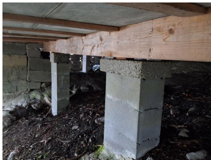
Utvendig - [Stubbloft, søylefundamenter og drager]
