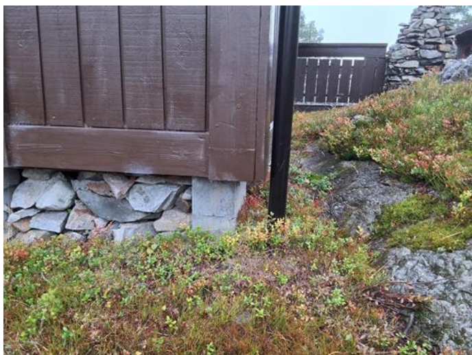
Utvendig - [Hjørne mot sør]
