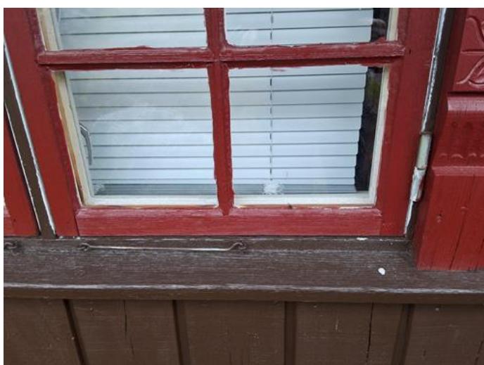
Utvendig - [Vindu på værutsatt vegg]
