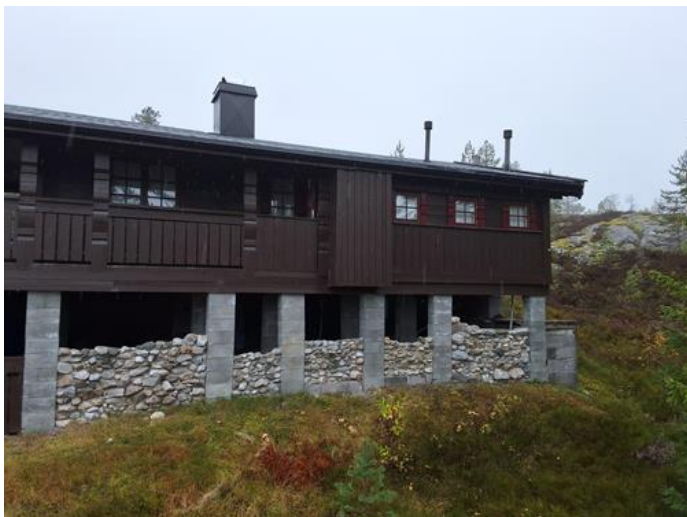
Utvendig - [Fundamenter og fasade]
