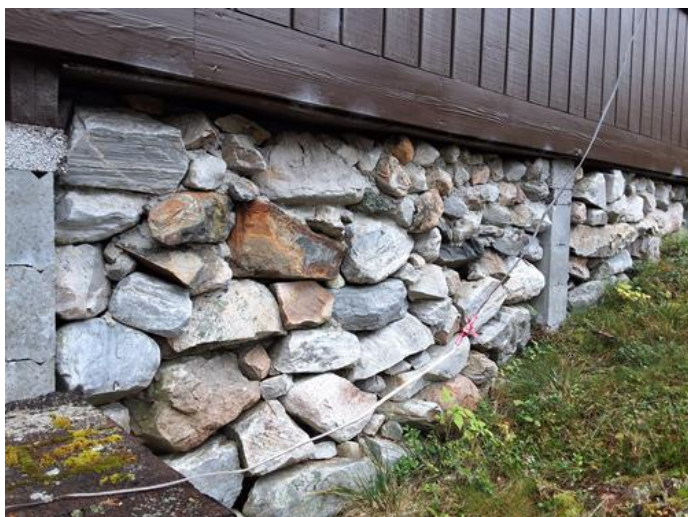
Utvendig - [Fundamenter og natursteinsmur]
