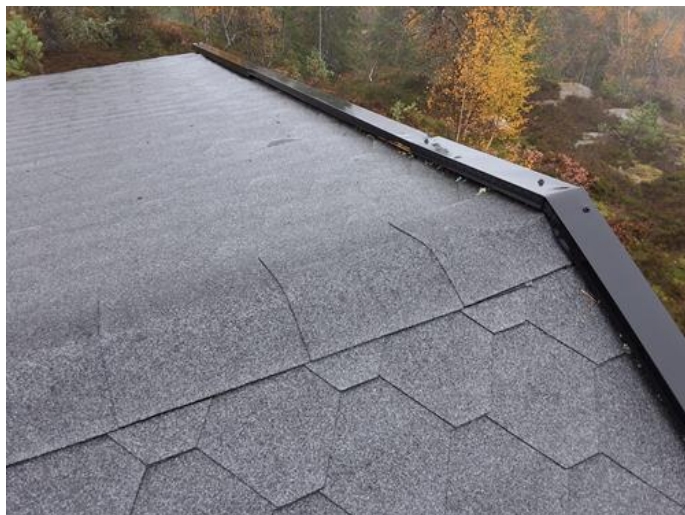
Utvendig - [Yttertak og israft beslag]
