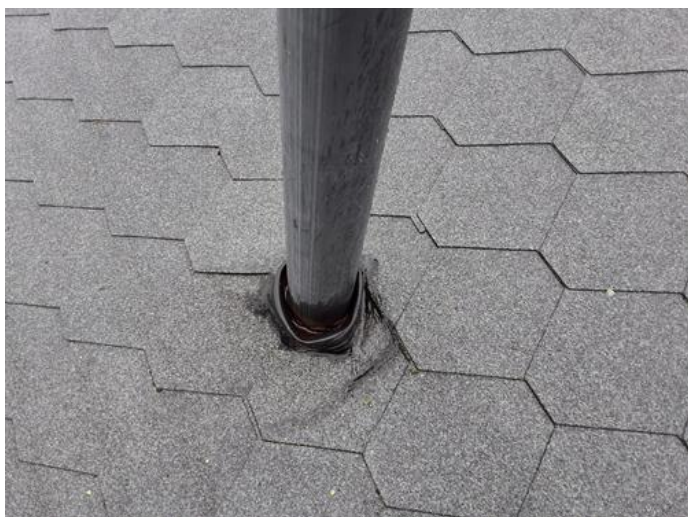
Utvendig - [Takgjennomføring, luftehatt]
