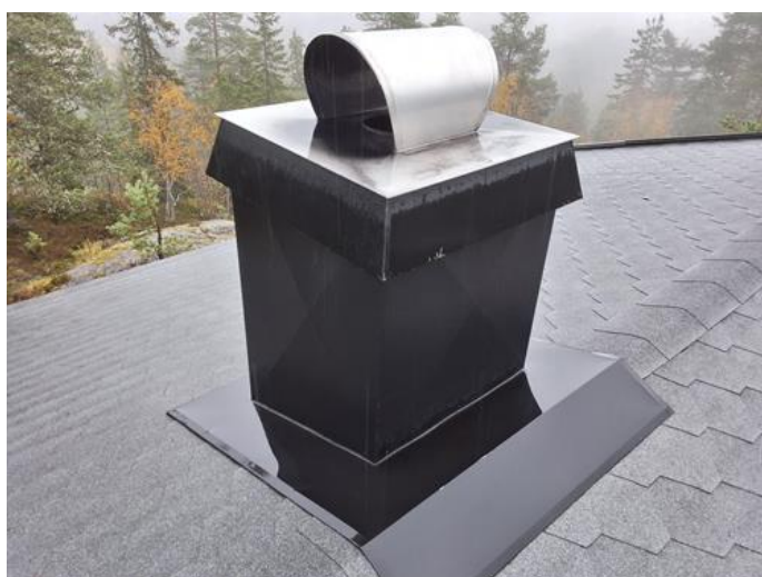
Utvendig - [Pipe over tak]
