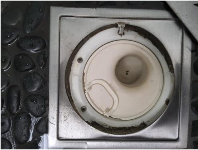
Avløpsrør (ink. sluk) - [Sluk på bad 2.]
