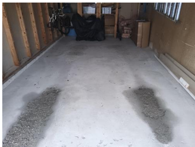
Overflater gulv - [Gulv i garasje.]
