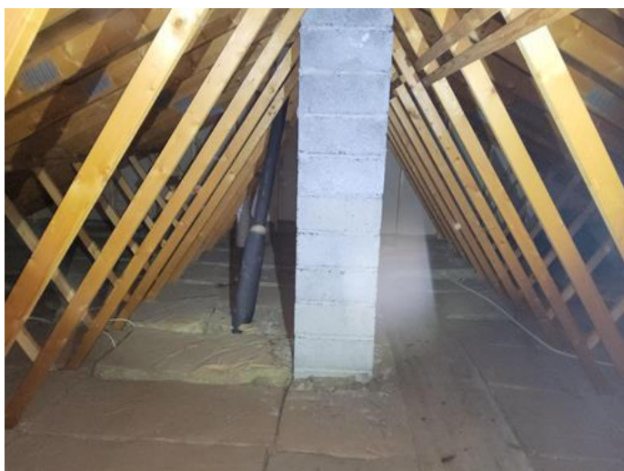
Loft - uinnredet / råloft - [Loft.]
