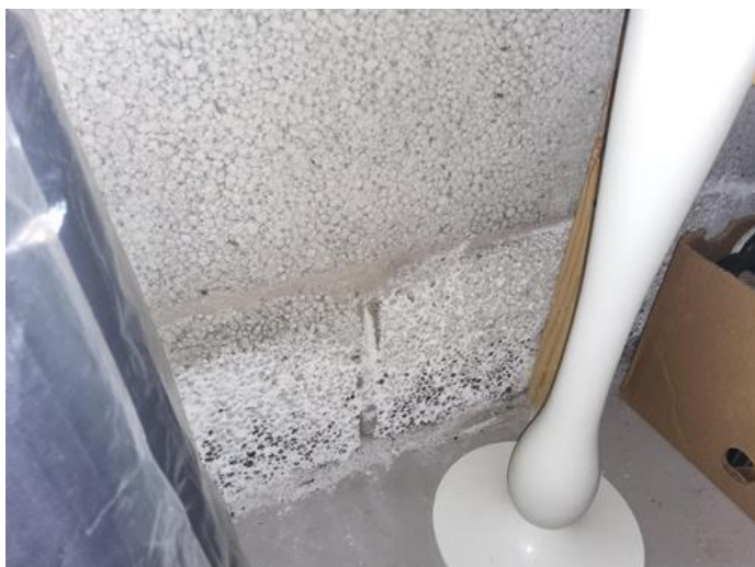
Overflater vegger - [Eksempel på fuktmerker på vegg i stor bod. ]
