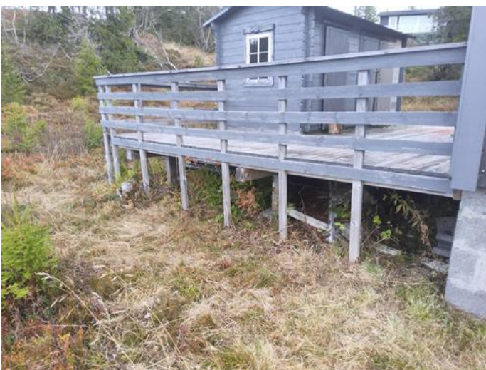
Utkragede eller understøttede konstruksjoner (balkonger, verandaer) - [Balkong mot nord.]
