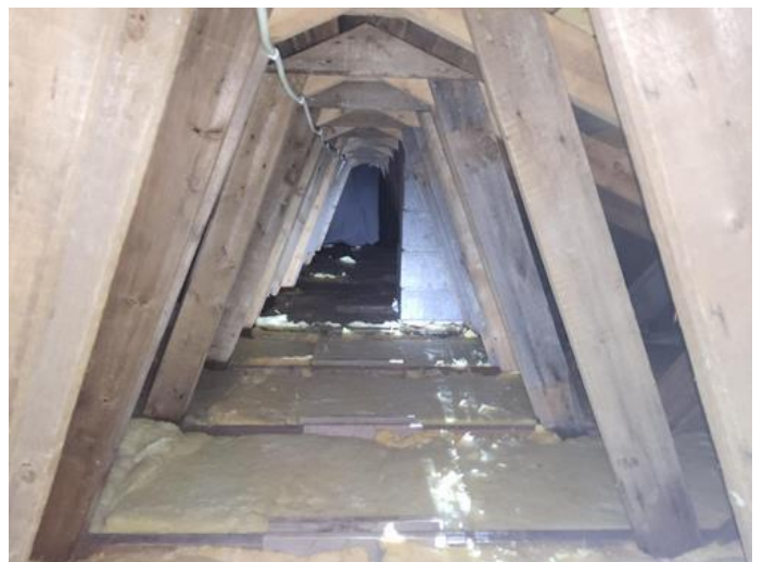
Loft - uinnredet / råloft - [Loft.]
