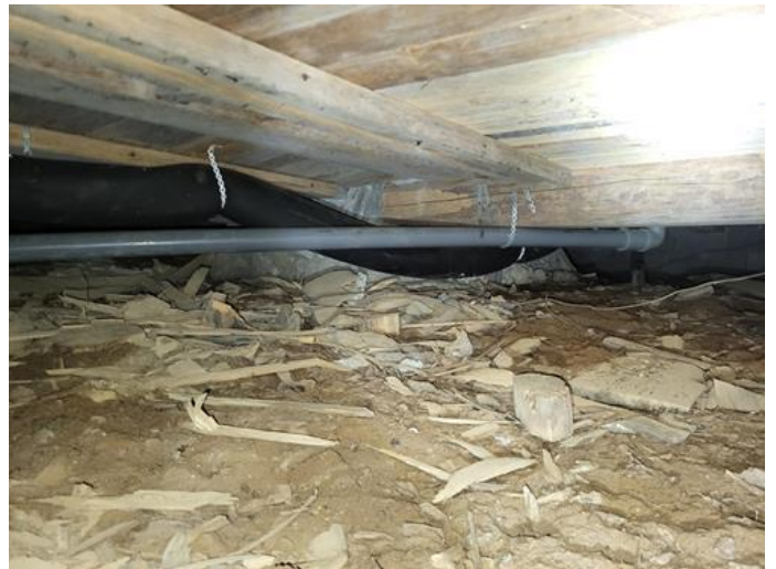
Krypekjeller - [Krypkjeller under opprinnelig del]
