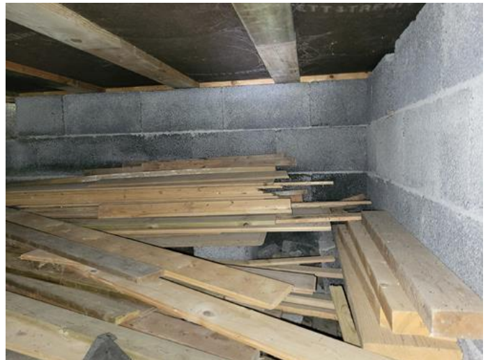
Krypekjeller - [Krypkjeller under tilbygg ]
