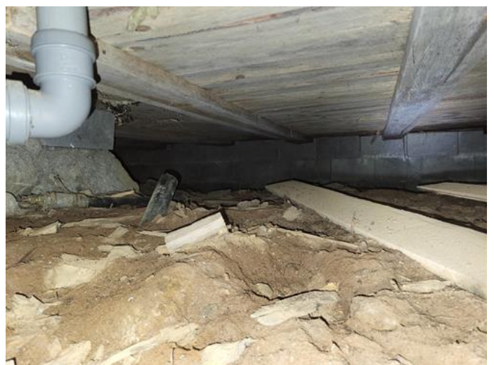
Krypekjeller - [Krypkjeller under opprinnelig del]
