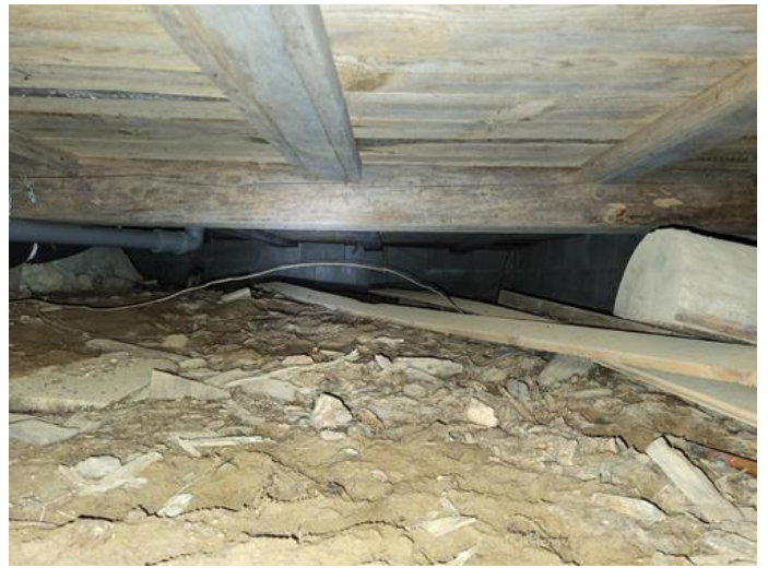
Krypekjeller - [Krypkjeller under opprinnelig del]
