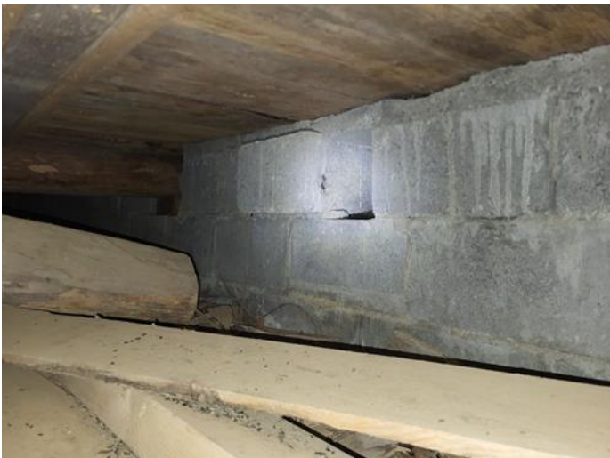
Krypekjeller - [Krypkjeller under opprinnelig del]
