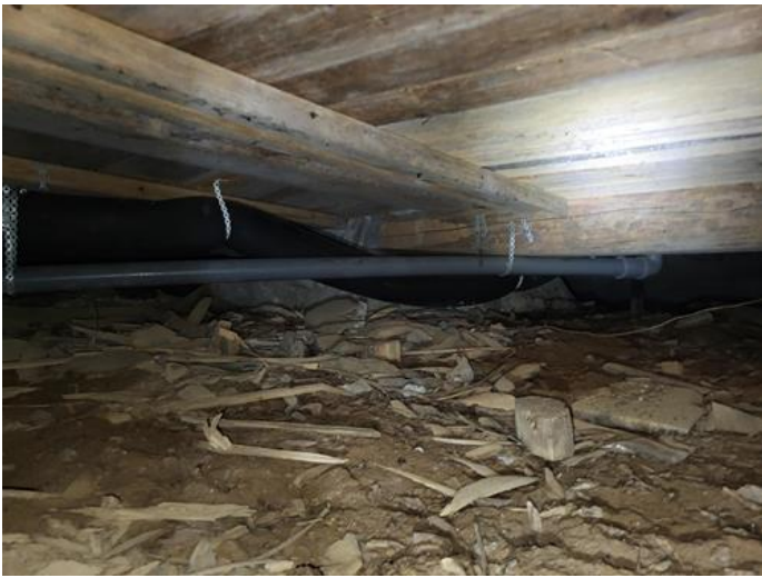
Krypekjeller - [Krypkjeller under opprinnelig del ]
