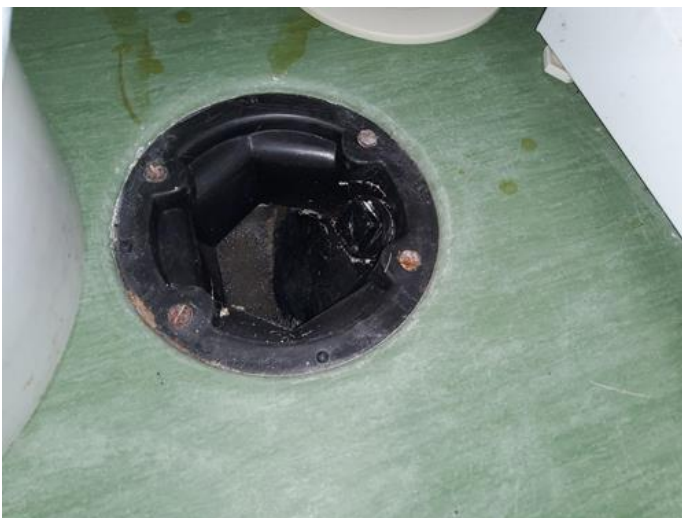
Våtrom - [Sluk vaskerom]
