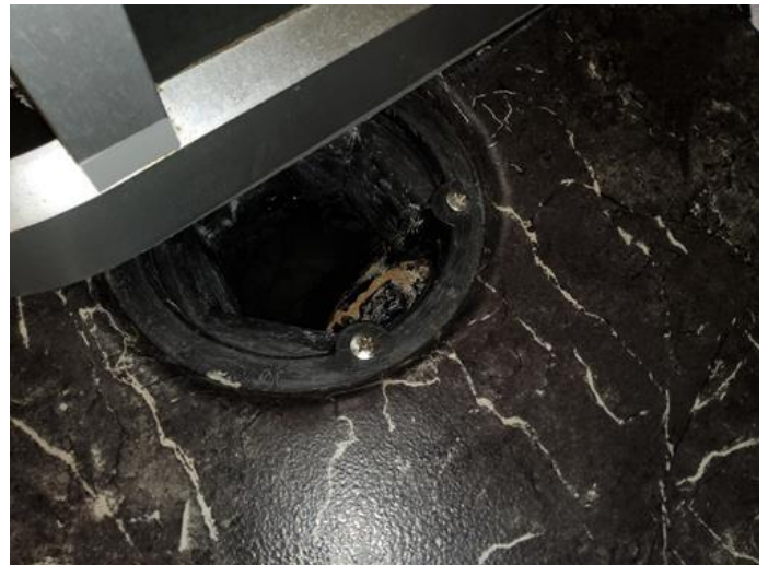
Våtrom - [Sluk bad]
