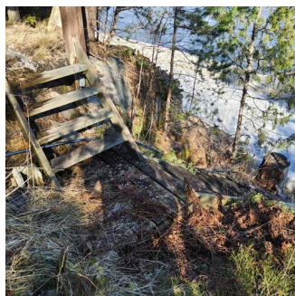
Utvendig trapp - Trapp i terreng
