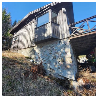
Grunnmur og fundament - Grunnmur og fasade
