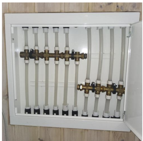
Tekniske anlegg, VVS anlegg (Sjekkpunkter utover det som er inkludert i andre rom) - [Fordelerskap for rør-i-rør system plassert på bad 1.etasje ]
