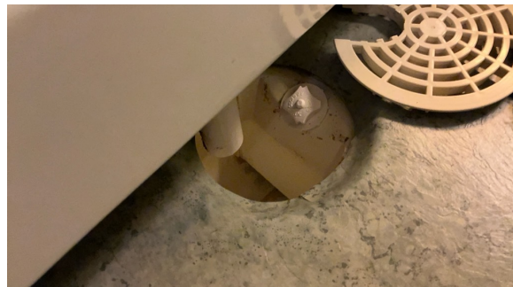
Sluk uten klemring.
