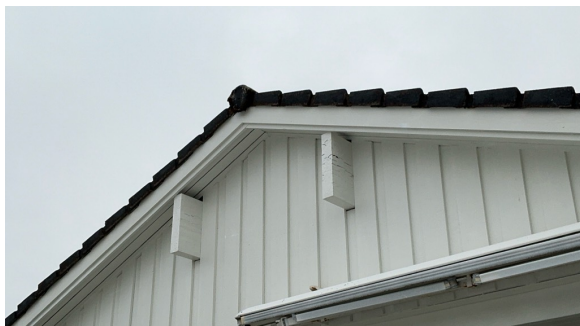
Råteskade i tredrager.
