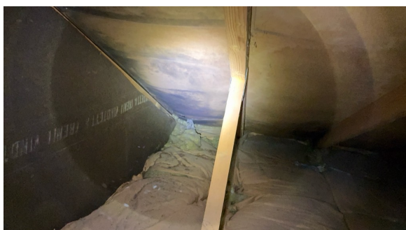
Råteskade i tredrager.
