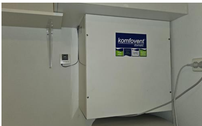
Ventilasjon - [Ventilasjonsaggregat.]
