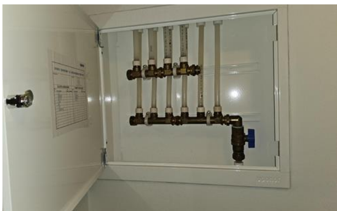
Vannrør (Sjekkpunkter utover det som er inkludert i andre rom) - [Fordelerskap.]
