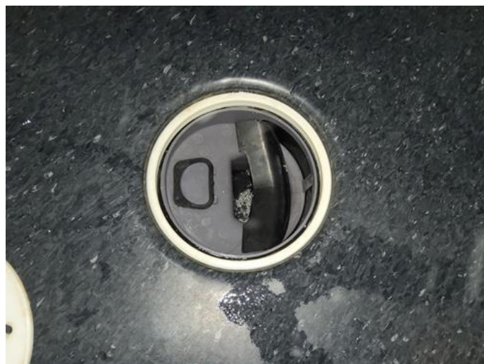
Membran, tettesjikt og overgang til sluk. - [Sluk dusjsone bad]
