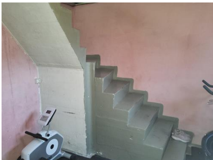
Innvendige trapper - [Trapp til kjeller.]
