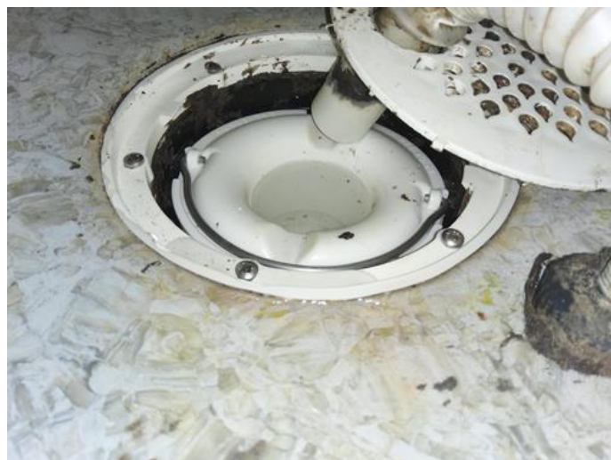
Avløpsrør (ink. sluk) - [Sluk på bad. ]
