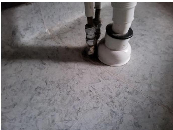
Membran, tettesjikt og overgang til sluk. - [Eksempel på rørgjennomføringer i gulv på bad. ]
