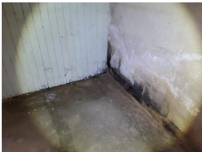
Rom under terreng (kjeller, underetasje, sokkeletasje) - [Eksempel på fukt i kjeller]
