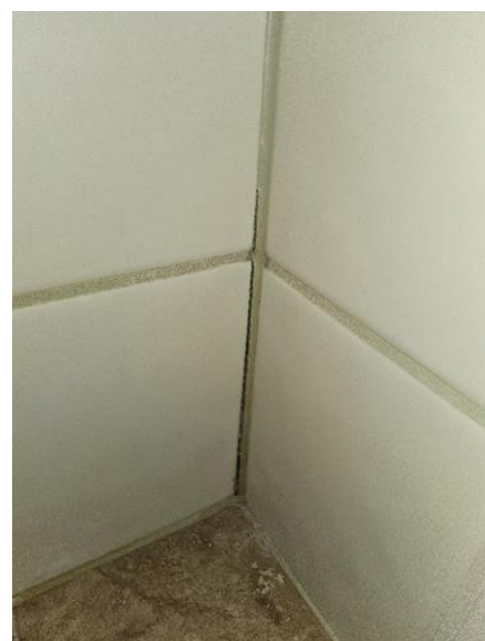
Overflater vegg - [Elastisk flisfuge i dusj]
