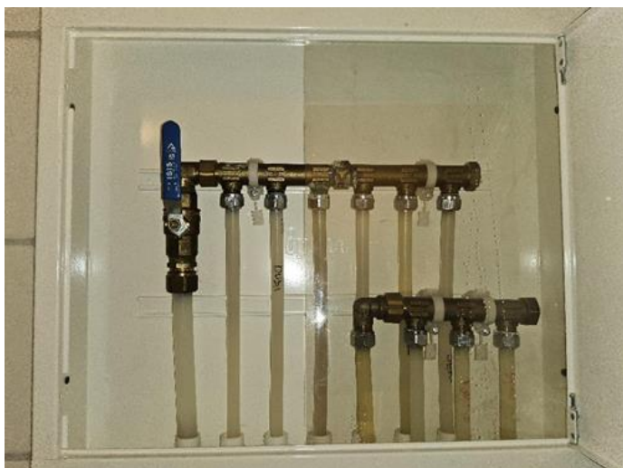
Vannrør (Sjekkpunkter utover det som er inkludert i andre rom) - [Samleskap for rør-i-rør systemet]
