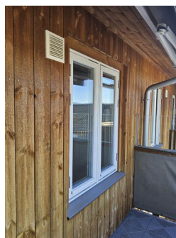
Vinduer og omramming - Vindu balkong
