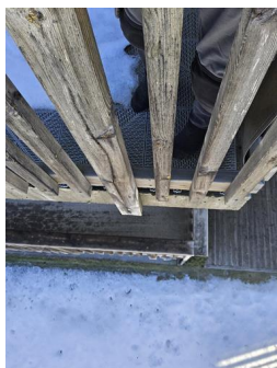
Tilstand på rekkverk og overflatematerialer - Rekkverk
