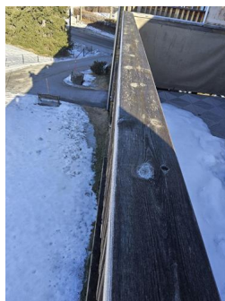
Tilstand på rekkverk og overflatematerialer - Rekkverk
