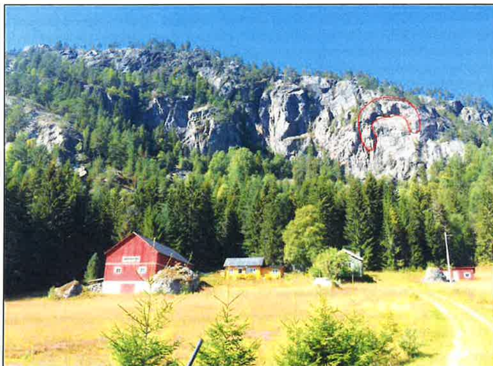
Figur 5. Området som er mest utsatt for steinras er merket med rødt på bildet.
