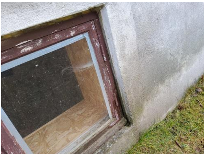
Annet - [Åpninger/utettheter rundt kjellervindu]
