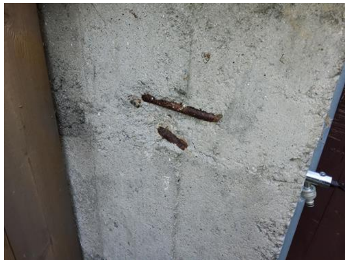
Beskrivelse - [Eksponert armering- Grunnmur]
