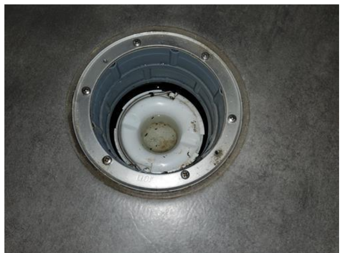
Våtrom - [Sluk vaskerom]
