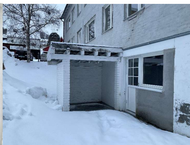
Takoverbygg og verandadør til leilighet i u.etc.
