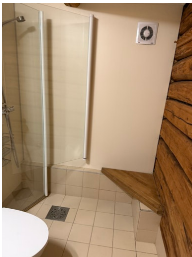
Bilde av tømmervegg på bad.
