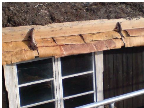
Bilde fra selger: Nytt tak på fjøs under utføring i 2008
