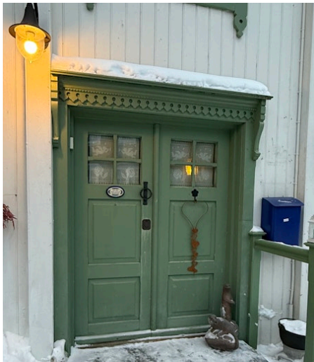
Ytterdør mot gate rehabilitert.
