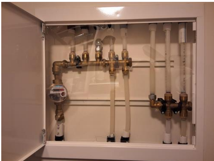
Tekniske anlegg, VVS anlegg (Sjekkpunkter utover det som er inkludert i andre rom) - [Fordeleskap vannrør]
