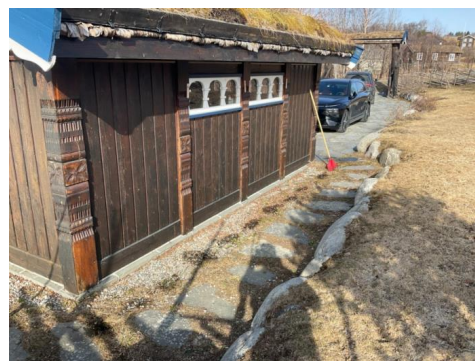
Rekke med store rundsteiner mot terrenget ved parkering og garasje.
