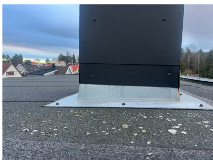
Beslag på utvendig pipe.
