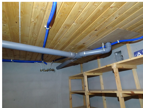
Nyere avløpsrør antatt fra 2010
