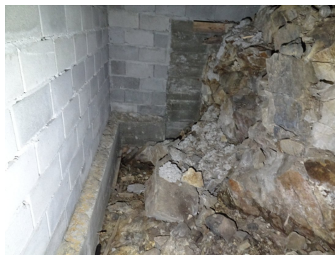
Betongsåle mot fjellgrunn, ventilerte betongblokker benyttet som grunnmur / ringmur. Dette er i sørvestre side (1975)
