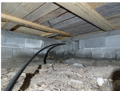
Bildet fra indre hjørne i første krypprom nordre hjørnet.
