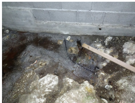
Støpt såle mot fjellet, grunnmur i leca, dette er i nordøstre side (tilbygg 1984)
