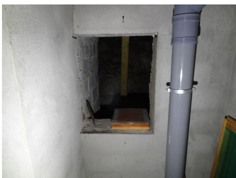
adkomst luken til første krypprommet
