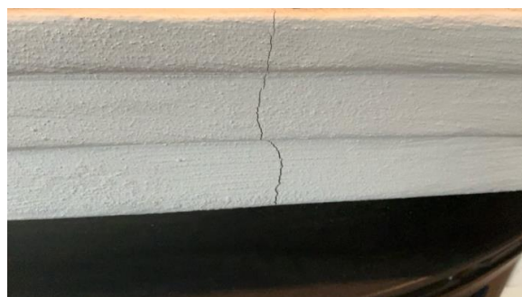
Sprekk i mur.
