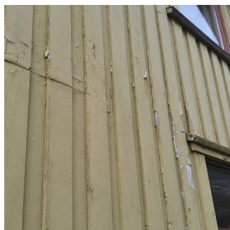
Helhetsvurdering - Eksempel på slitasjer
