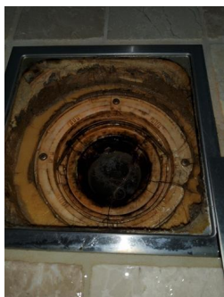
Tettesjiktets tilslutning til sluk - Sluk bad hoved-del
