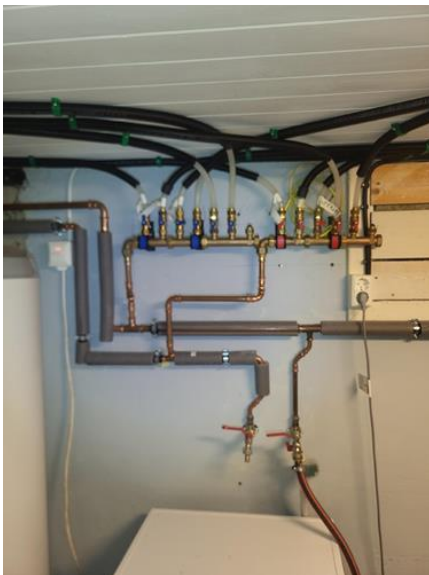
Tekniske anlegg, VVS anlegg (Sjekkpunkter utover det som er inkludert i andre rom) - [Koblingspunkt for vannrør på vaskerom ]
