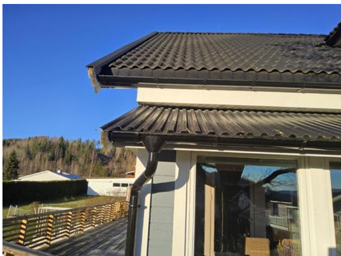
Utvendig - [Yttertak, blikktak til utestue]
