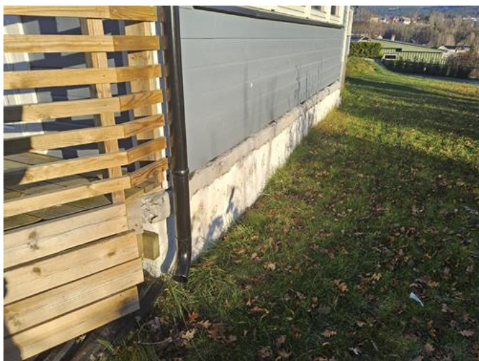
Utvendig - [Gammel terrasse]
