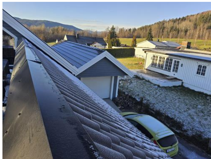
Utvendig - [Tak over kott/bod på takterrasse]
