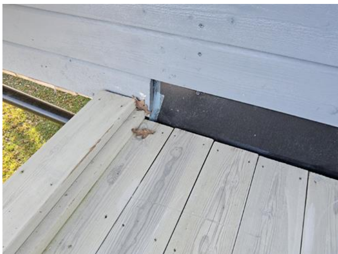
Utvendig - [Overgang inn på vegg fra takterrasse]
