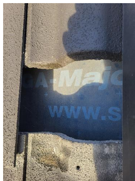
Utvendig - [Yttertak, pustene undertak]
