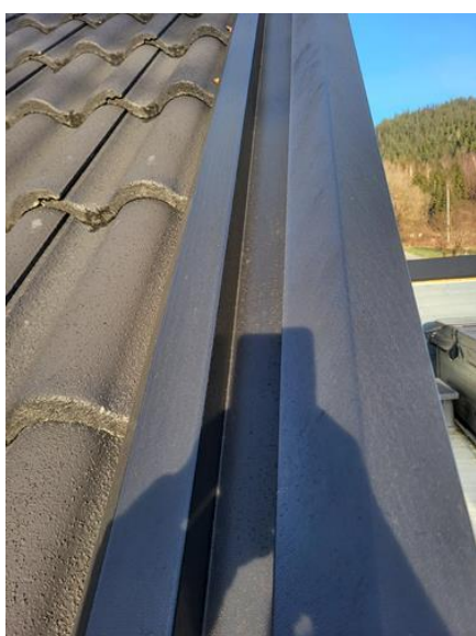
Utvendig - [Yttertak, stedvise skottrenner mot vindskier]
