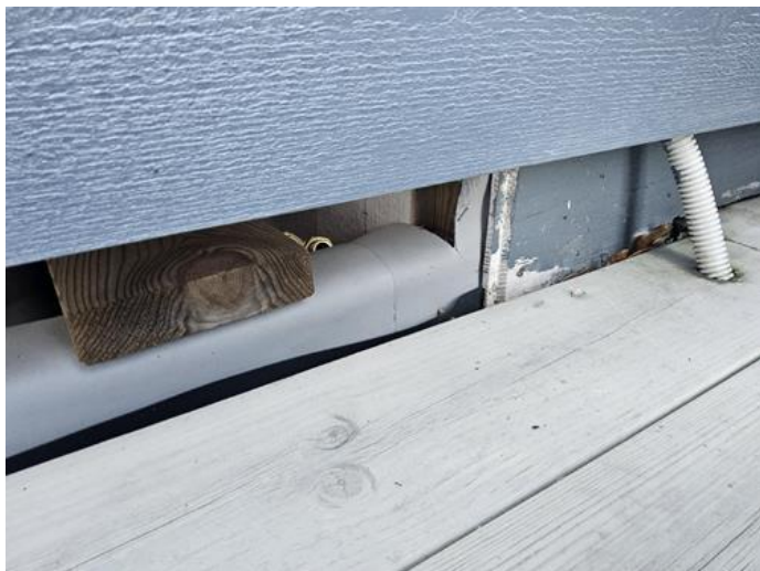
Utvendig - [Overgang sarnafil membran ]
