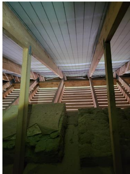
Loft - uinnredet / råloft - [Loft ]
