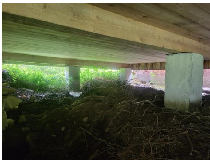
Utvendig - [Fundamenter under hytte ]
