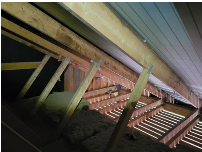
Loft - uinnredet / råloft - [Loft ]
