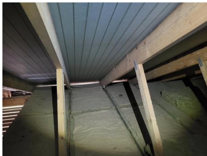
Loft - uinnredet / råloft - [Loft]
