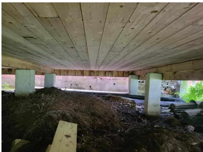
Utvendig - [Fundamenter under hytte ]
