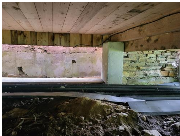
Utvendig - [Fundamenter under hytte ]
