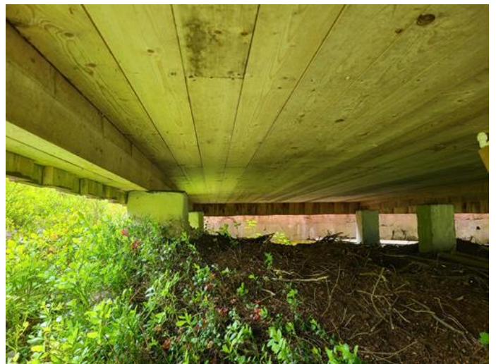
Utvendig - [Fundamnetter under hytte ]
