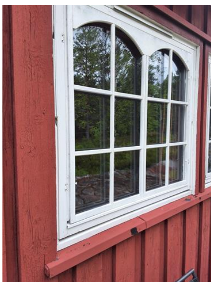
Yttervegger inkl. fasader og konstruksjon - [Vinduer]
