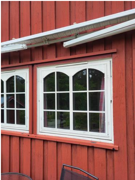
Yttervegger inkl. fasader og konstruksjon - [Vinduer]
