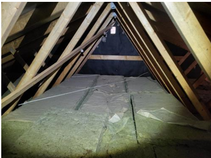
Loft - uinnredet / råloft - [Loft ]
