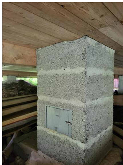
Utvendig - [Pipe og sotluke under hytte]
