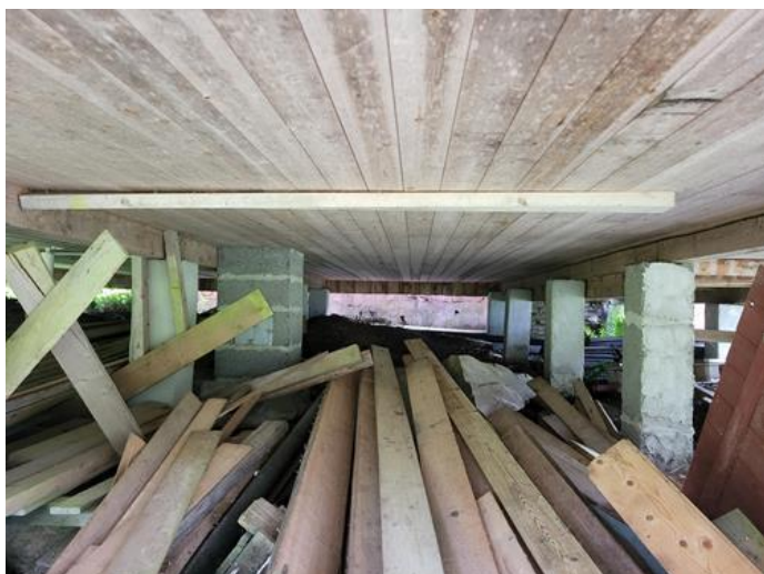
Utvendig - [Fundamenter under hytte]
