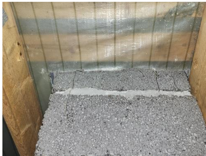
Loft - uinnredet / råloft - [Pipe, ved undertaket]
