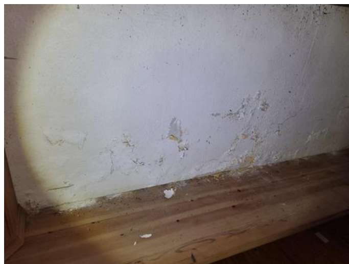
Kommentar - [Eksempel på avflassing i kjeller]
