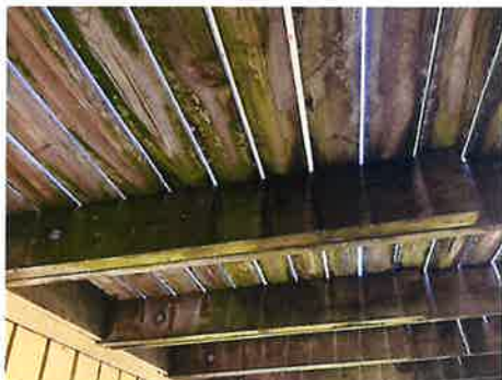
Råteskader på rekkverksstolpen
