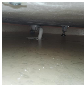
Helhetsvurdering - Sluk under dusjkabinett
