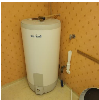
Varmtvannsbereder - Varmtvannsbereder og hovedstoppekran plassert på bad
