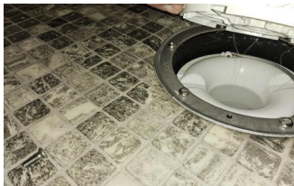
Tettesjiktets tilslutning til sluk - Sluk i dusjsonen.
