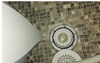
Tettesjiktets tilslutning til sluk - Sluk under badekar.
