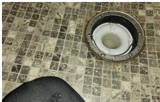
Tettesjiktets tilslutning til sluk - Sluk i dusjsonen.
