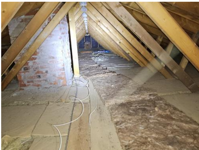
Loft - uinnredet / råloft - [Kaldtloft]
