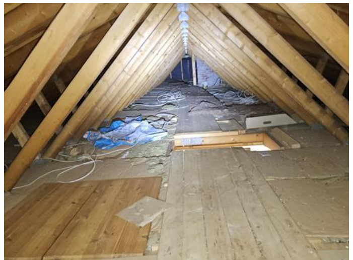
Loft - uinnredet / råloft - [Kaldtloft]
