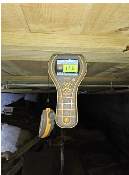
Krypekjeller - [Fuktmåling krypekjeller]
