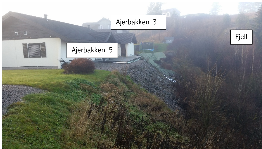
Figur 3: Bilde tatt fra øst og viser et oversiktsbilde av rasområdet
