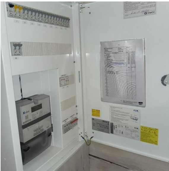
Elektrisk anlegg - [Sikringsskap og kursoversikt plassert i soverom]
