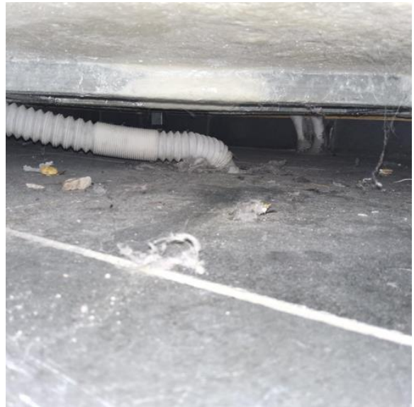
Innvendig - [Sluk under dusjkabinett bad 1.etasje ]
