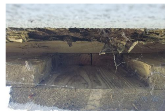
Lufting av ytterkledning - noe mindre lufting
