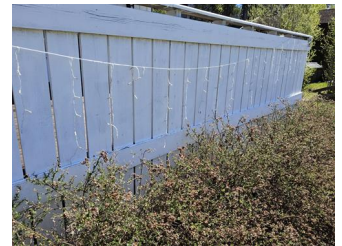
Tilstand på rekkverk og overflatematerialer - -
