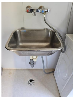
Sanitærutstyr og innredning - Vaskerom fra byggeår
