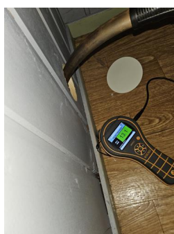
Utført kontroll i tilliggende konstruksjon - Målinger mot vegg
