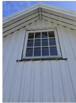
Vinduer, dører og porter - -
