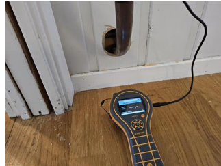
Utført kontroll i tilliggende konstruksjon - -
