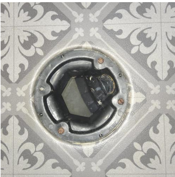
Våtrom - [Sluk bad 1.etasje ]
