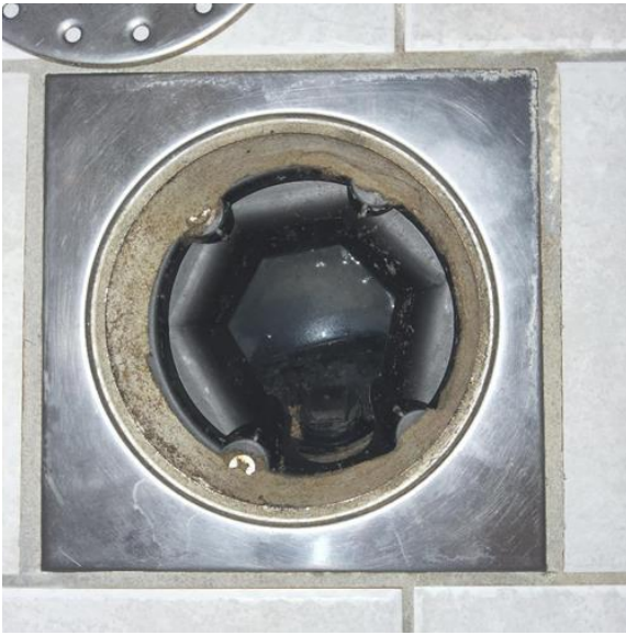
Våtrom - [Sluk bad underetasje ]
