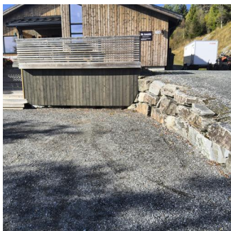
Rekkerkshøyde og lysåpninger - Forstøtningsmur i gårdsplass
