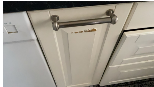
Det er påvist skader på overflater/kjøkkeninnredning utover normal slitasjegrad.
