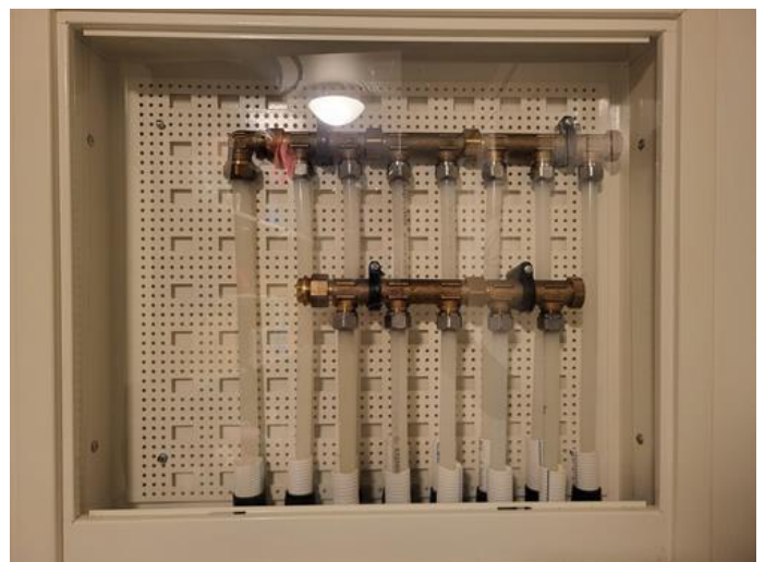
Tekniske anlegg, VVS anlegg (Sjekkpunkter utover det som er inkludert i andre rom) - [Fordelingskap vannrør]
