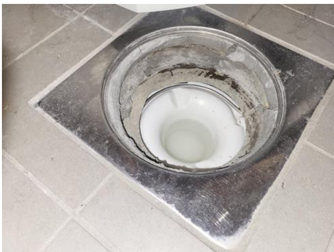
Våtrom - [Sluk vaskerom]
