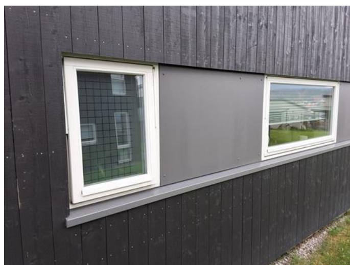
Utvendig - [Fasadeplater mellom vinduer]
