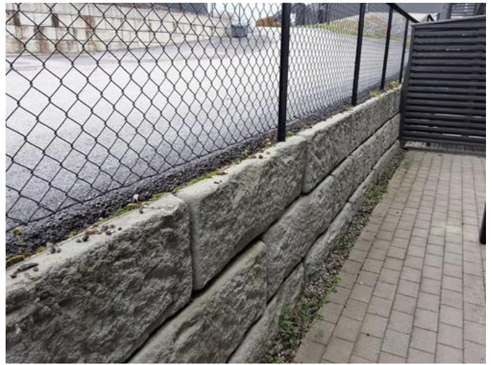
Utvendig - [Støttemur mellom gårdsplass og inngang]
