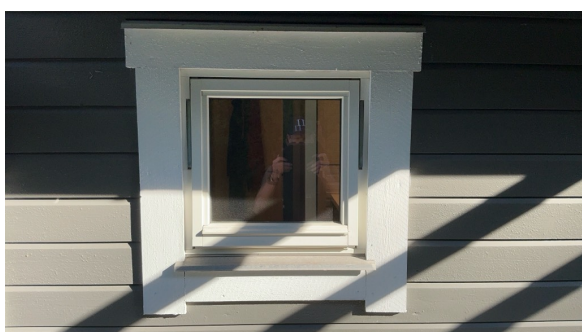
Vindu bad fra 2009.
