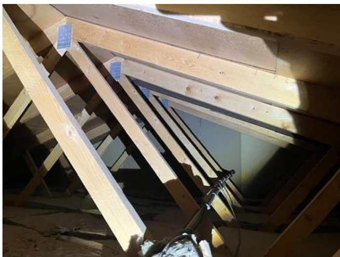
Loft - uinnredet / råloft - [Loft]
