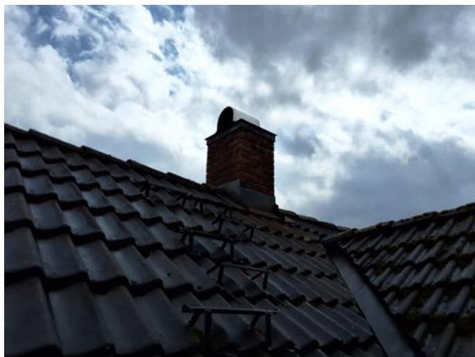
Utvendig - [Kilrenne og stigetrinn]
