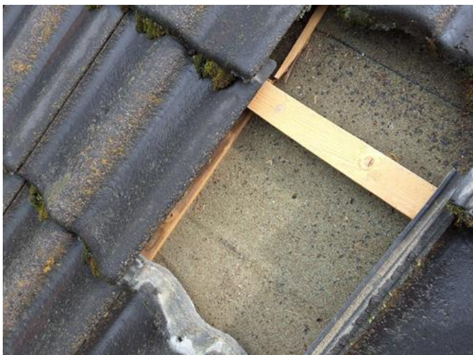
Utvendig - [Undertak og lekter eldste del. ]
