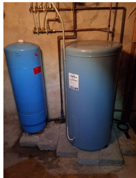
Varmtvannsbereder (Sjekkpunkter utover det som er inkludert i andre rom) - [VVB og trykktank]
