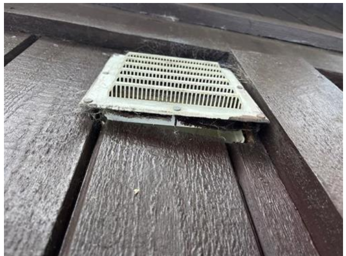
Yttervegger inkl. fasader og konstruksjon - [Løs sjalusirist ventil til soverom]
