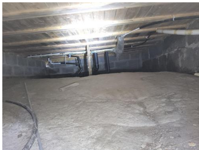
Krypekjeller - [Krypekjeller under tilbygg mot øst.]
