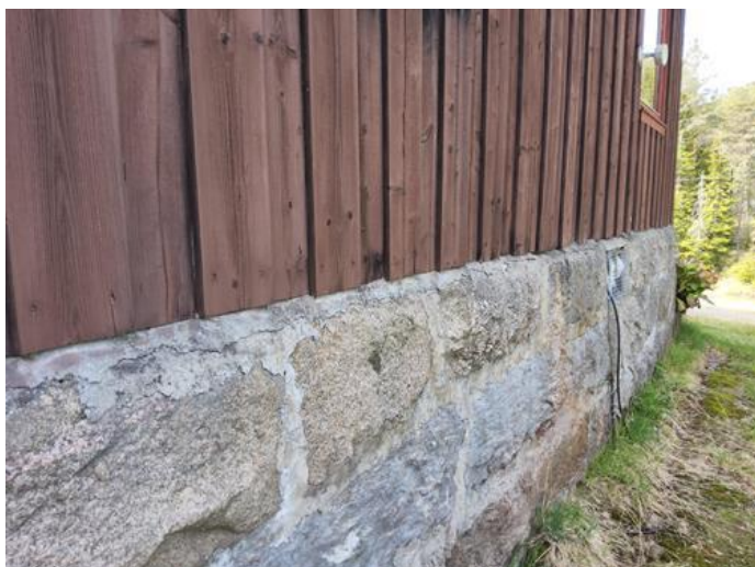
Yttervegger inkl. fasader og konstruksjon - [Eksempel på kledning avsluttet ned mot grunnmur. ]
