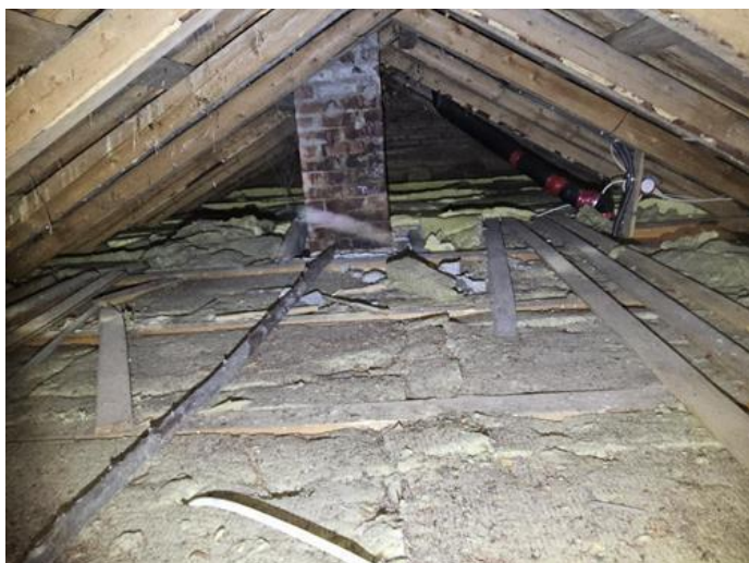
Loft - uinnredet / råloft - [Kaldtloft]
