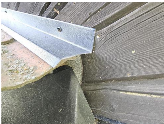
Yttertak - [Overgang vegg/tak]
